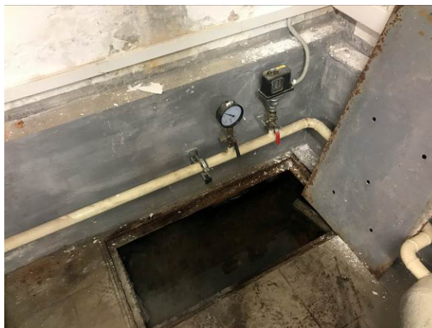
Foto č.6 – Jímka na spodní vodu o rozměru 1000x 500 mm
