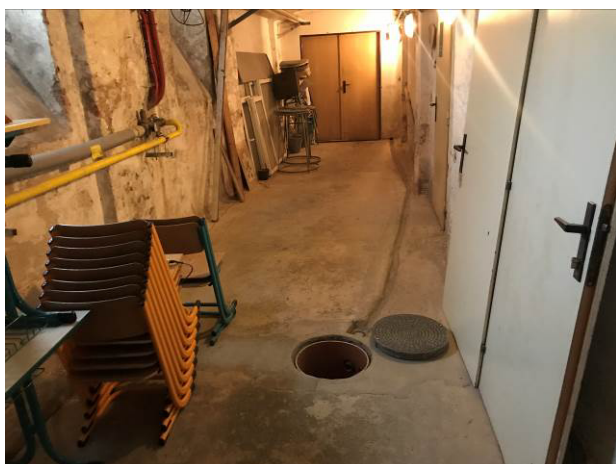
Foto č.17 – Nová šachta v chodbě – nové šachty jsou propojeny
